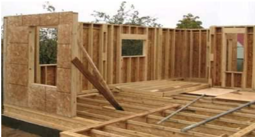
1 сурет – Қаңқалы-қалқан ағаш үйі монтаждау процесінде
