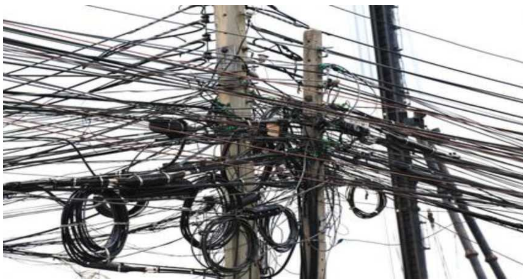
3 сурет – Бір тіреуішке бекітілген қосылу нүктелері санының артуы
