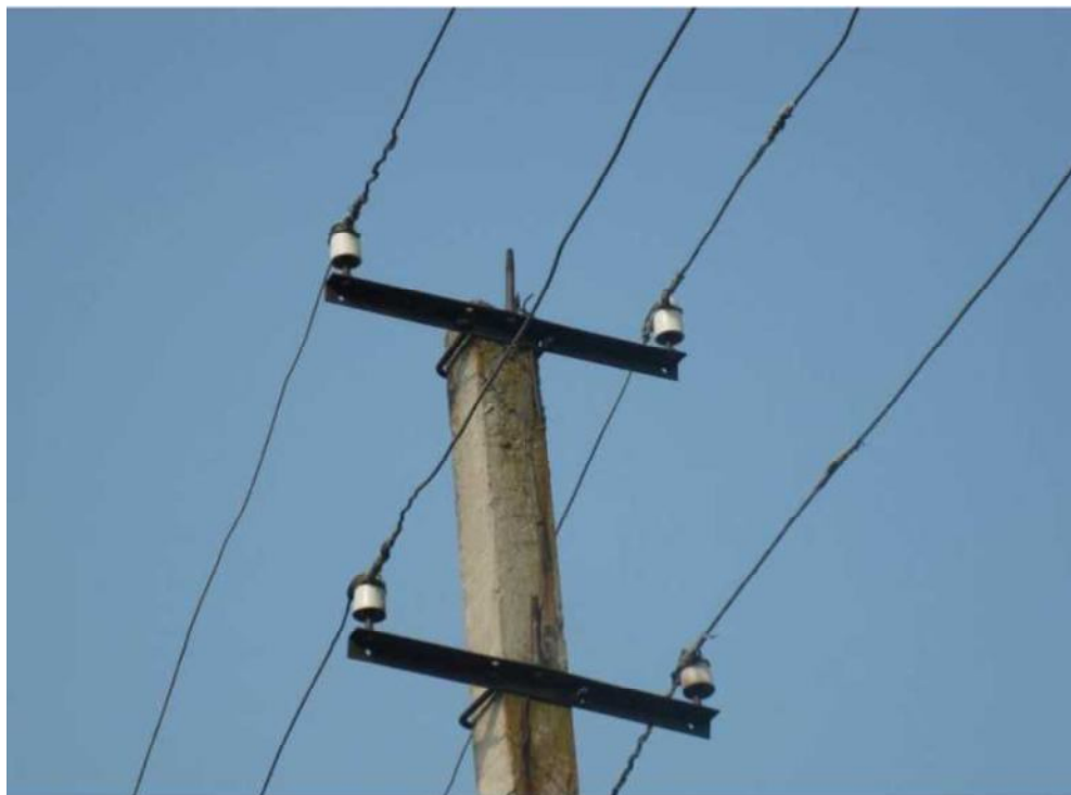
1 сурет – Оқшауланбаған сымдардан жасалған электр жеткізуші желі
